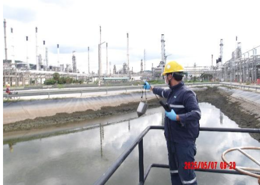
รูปที่ 2-7 บ่อพักน้ำจากกระบวนการผลิต ขนาด 1,505 ลูกบาศก์เมตร (Blowdown Pond T-86119)
